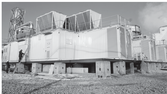
Строительство энергоцентра — завершён монтаж оборудования
