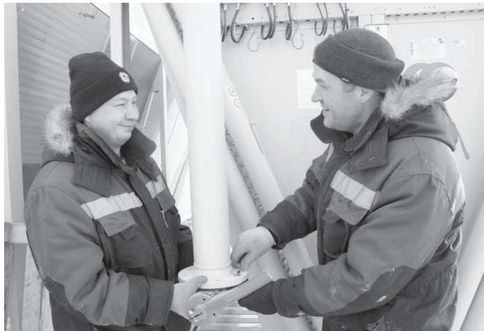
Специалисты фирмы «ИНТМА» монтируют задвижку системы охлаждения
